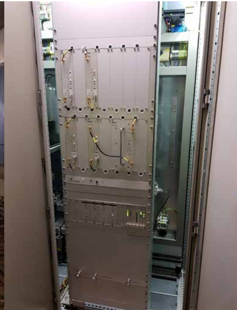
HF-installatie bij overkapping Rijswijk (spoor) met componenten die aangepast zijn door her inzet van onder andere componenten uit de Westerscheldetunnel.
