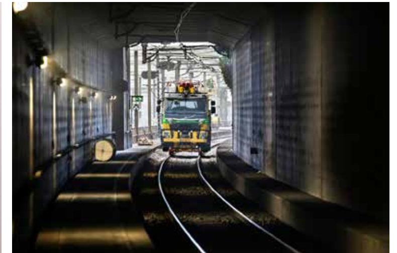
Werzaamheden ProRail aan de Willemsspoortunnel.
