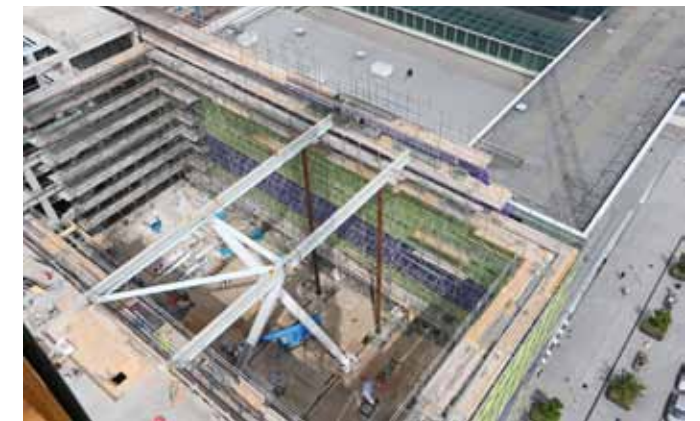
In de bouwvak werd gewerkt aan de plaatsing van tonnen zware kolommen
