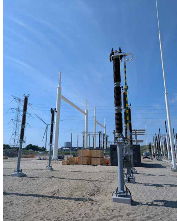
De plaatsing van veldstaal en hoogspanningscomponenten door SC&M. (Beeld: Croonwolver&dros)
