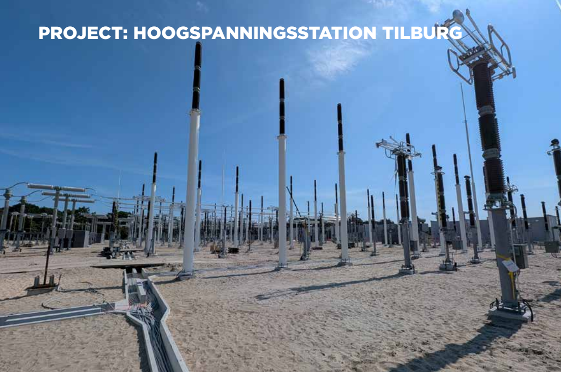
De plaatsing van veldstaal en hoogspanningscomponenten door SC&M. (Beeld: Croonwolver&dros)
