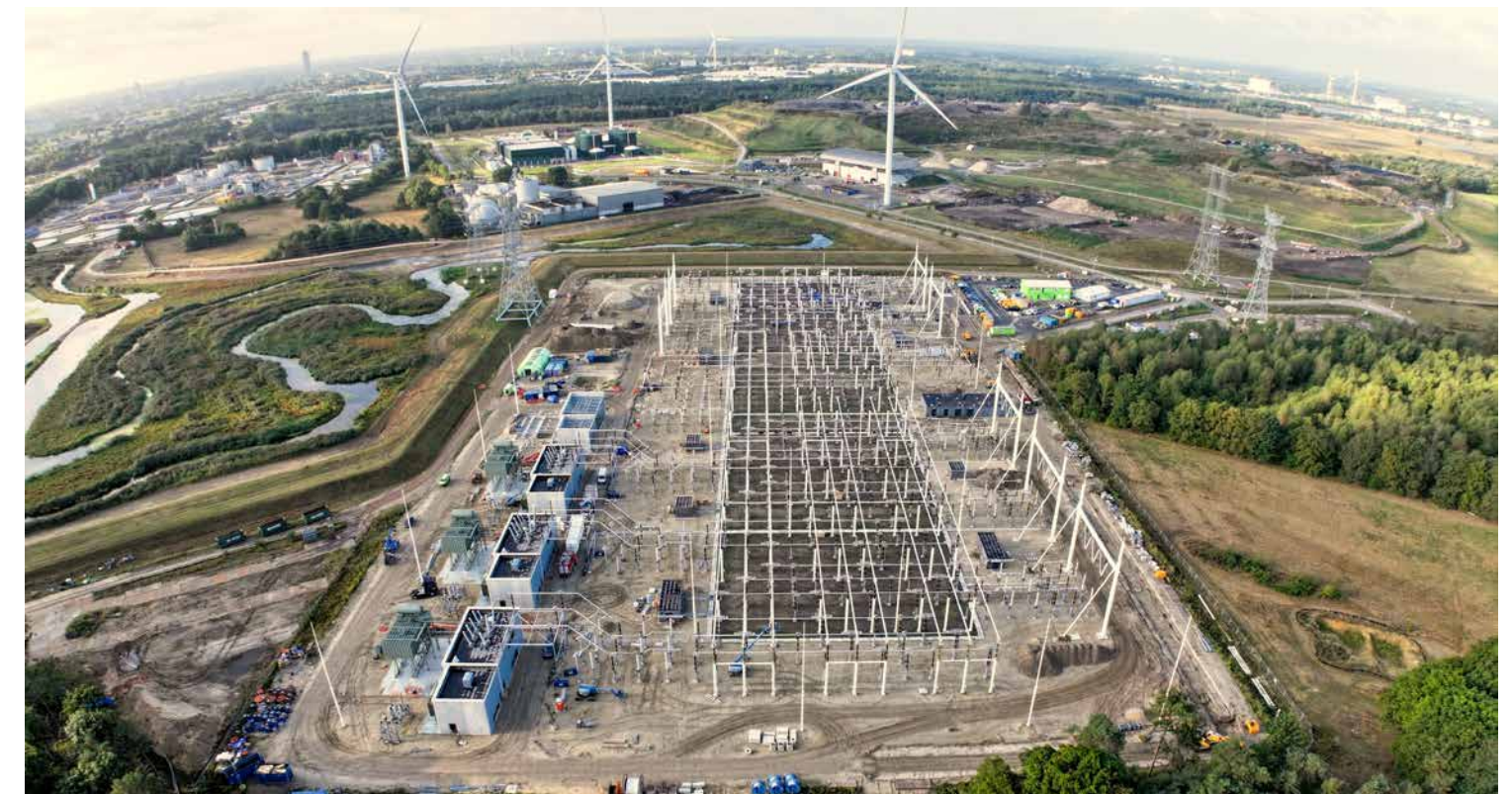
Het hoogspanningsstation in Tilburg in aanbouw. (Beeld: Koen van Rens)
