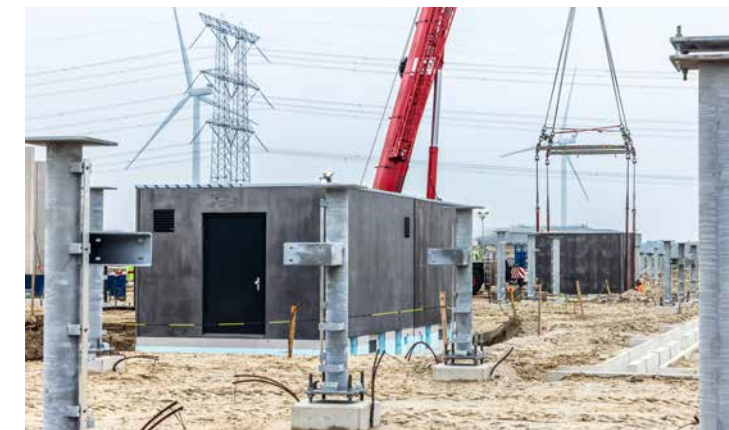
De plaatsing van veldhuizen door SC&M. (Beeld: Mobilis)
